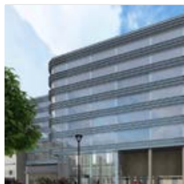
Реконструкция здания автостоянки под БЦ «Сенатор»
